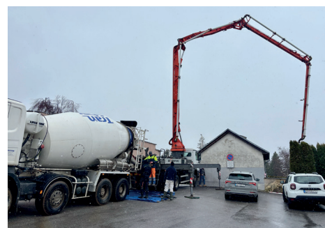
Postupná obnova Domu smútku – práce na strope, realizácia novej podlahy aj betónáž podkladu sú súčasťou komplexnej rekonštrukcie interiéru.
